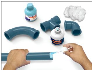
**Paso 4:** Encaje de una vez las extremidades que se vayan a soldar, realizando un leve movimiento de rotación entre las piezas 1/4 vuelta hasta que alcancen la posición definitiva. Encajar las partes y remover cualquier exceso de adhesivo y espere 1 hora para llenar la tubería de agua y 12 horas para hacer la prueba de presión.
